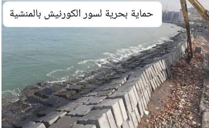
شكل 27. حماية بحرية لسور الكورنيش بالإسكندرية. المصدر: الهيئة المصرية العامة لحماية الشواطئ
